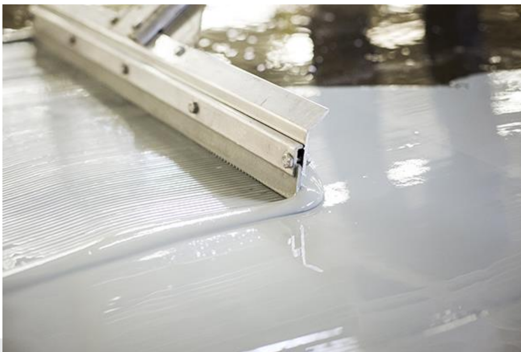
Foto: Aanbrengen vloeistofdichte beschermlaag.
