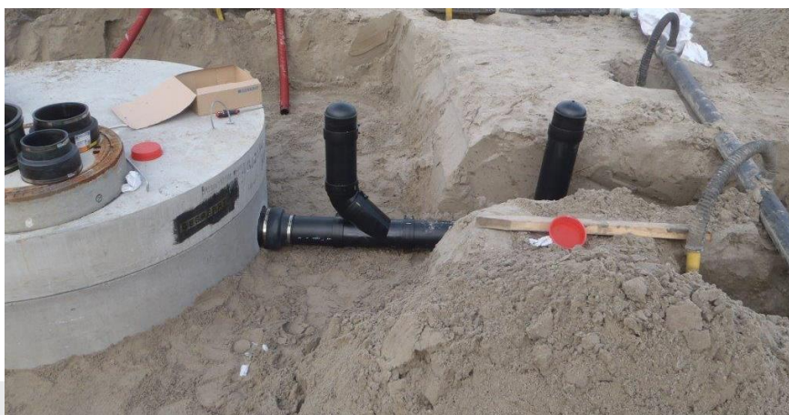
Foto: Voorbeeld van voorzieningen voor controle van de bedrijfsriolering op waterdichtheid. Aansluiting van de bedrijfsriolering (hulp) op de prefab betonnen slibvangput.
